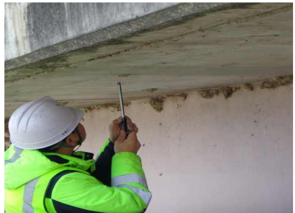
탄산화깊이 측정 현황
