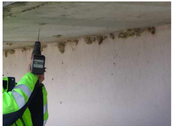
탄산화깊이 측정 현황
